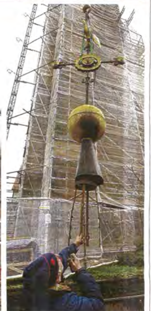
Mit einem großen Autokran wird der Turm vom Dach gehievt (oben). Doch zuvor müssen Gilbert Ritz, Erich Seifert und Wilfried Philipp (Bild links, von links) die Turmspitze in luftiger Höhe lösen. Hernach ist der Kran am Zug und anschließend schwebt die Spitze sanft in Richtung Boden, wo sie Seifert mit Hilfe der Flachstelen festhält.
