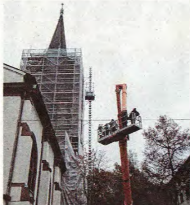
Per Hubsteiger geht es 72 Meter in die Höhe.
